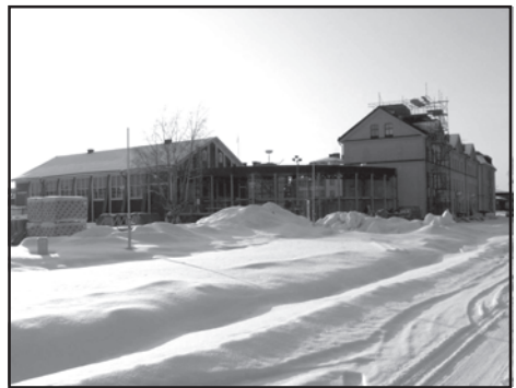
Försvarsmuseet under byggnation. Å8 gamla gymnastisal till vänster på bilden.
